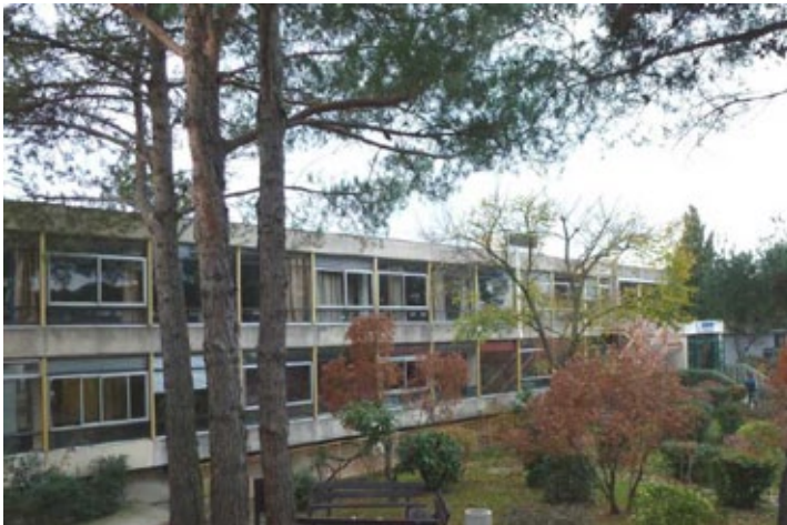
Le CVRH un bâtiment contigu à celui de l'ENTE
